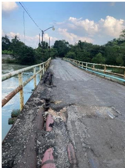
Figura 3. Puente ubicado en El Sitio, Nacajuca.
